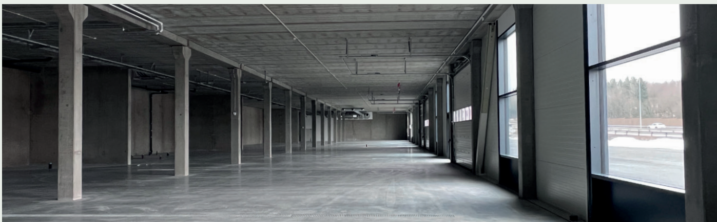
Betomast Romerike har satt opp bygget i en totalentreprise.
